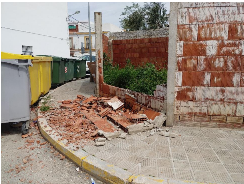
Marchena. Muro aislado (categoría Z) derribado. IF \geq 1
